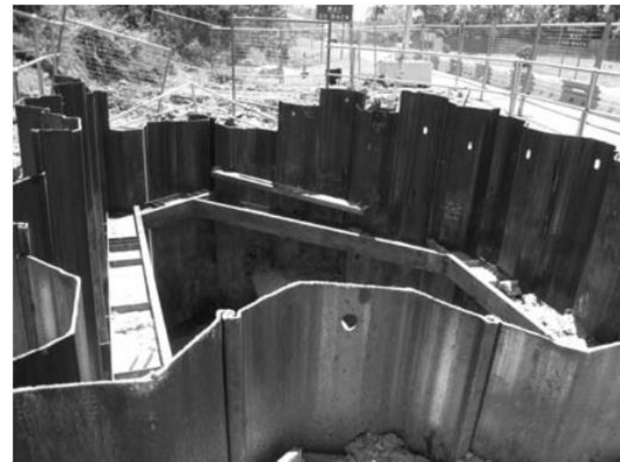
یک محفظه از سپر برای عملیات حفاری
